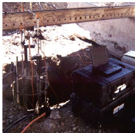
O-Cell 测试设备的安装
