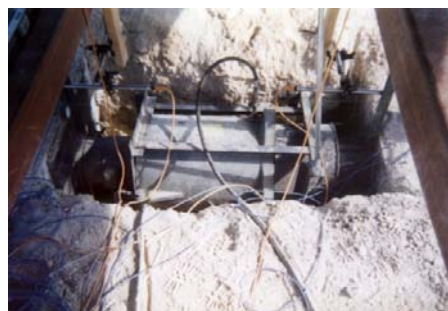
传统的桩基横向荷载测试
