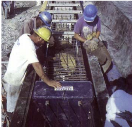
安装 0-Cell 于预制混凝土试桩
