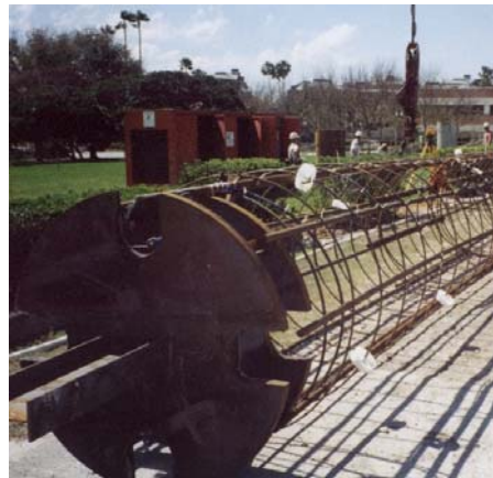
单级 O-Cell 组装准备安装
