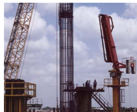
O-Cell 试验的成功经验从 4.5-107 米钻孔桩到 40 米长的预制打入桩。
