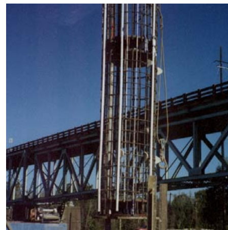
多层 O-Cell 组合试验
