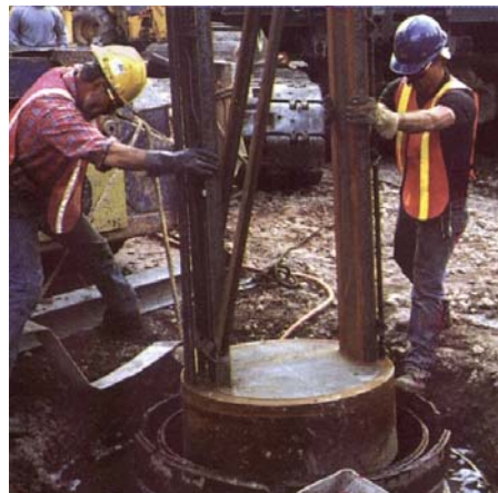
钢框架可以用来将 O-Cell 安装就位
