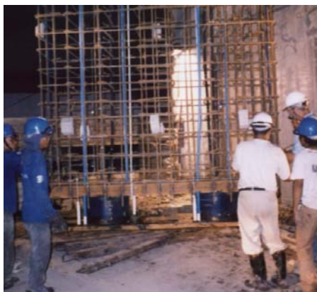
安装 0-Cell 组合于泥浆墙
